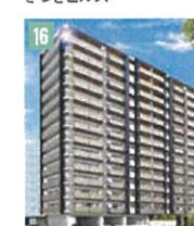
2014年8月竣工 (78戸) ワイズエステムコート 壺川駅前
