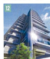
2013年4月竣工 (52戸) ワイズエステムコート 安里国際通り
