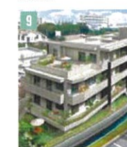
2011年10月竣工 (14戸) ワイズガーデン 中原テラス
